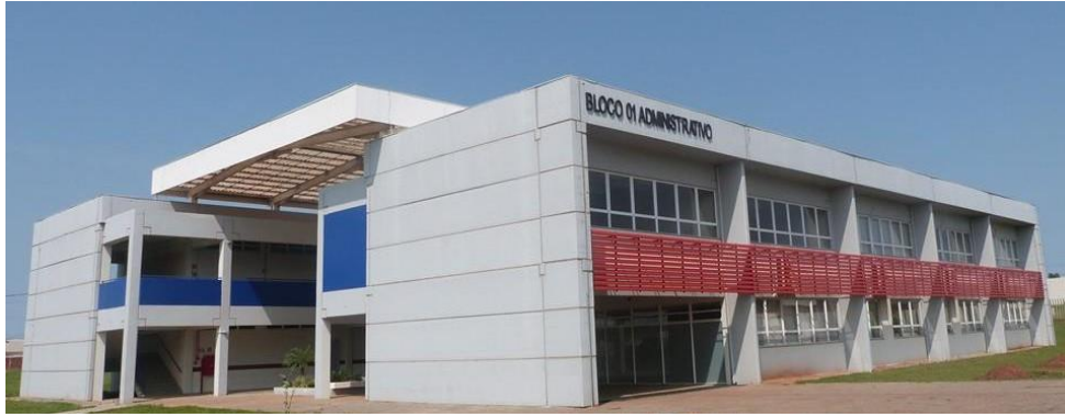
Figura 27 – Foto do Bloco 01 Administrativo – IFPR Campus Paranavaí
