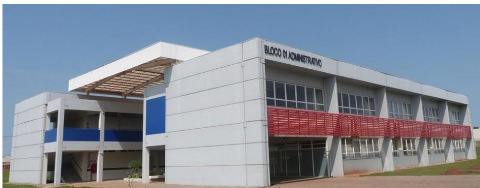
Figura 4 – Foto do Bloco 01 Administrativo – IFPR Campus Paranavaí
